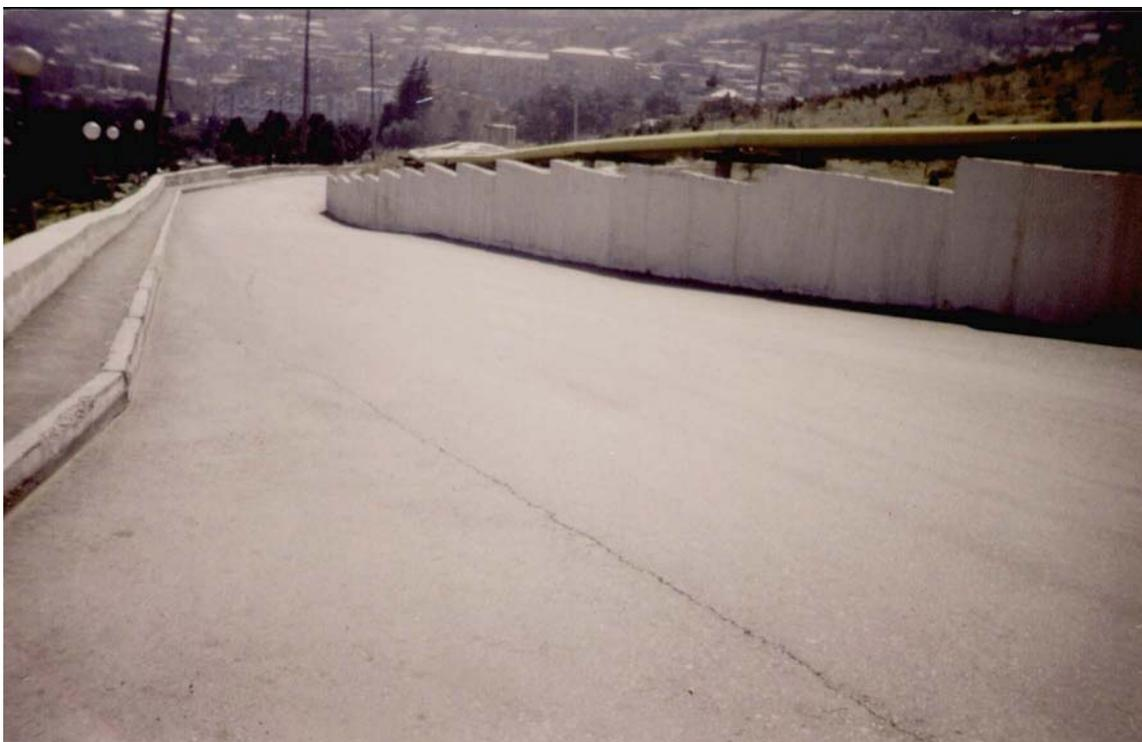
Рис. 5. Трещины, возникшие в оползневой зоне в результате автодорожного строительства
